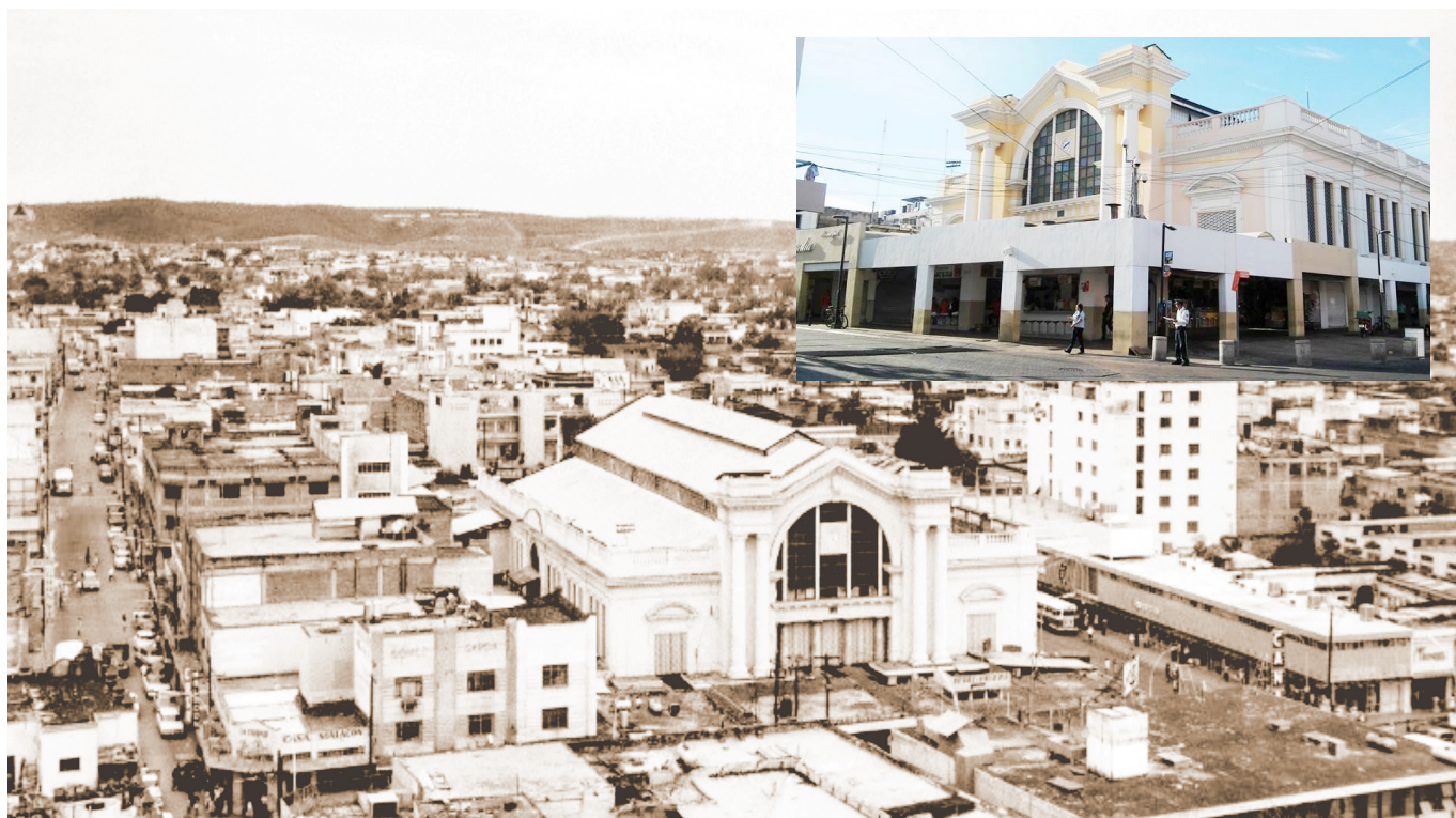
Por disputas entre el Ayuntamiento, locatarios y ambulantes, en 1918, el gobierno municipal presidido de manera provisional por Juan J. Morales aprobó la instalación de los primeros quince puestos fijos instalados en la parte externa del edificio del mercado.
