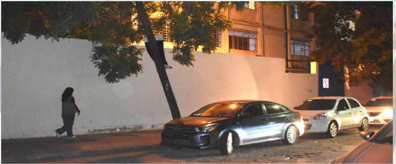
Barda perimetral trasera del Hospital Civil de Culiacán. Foto Rosendo Romero Guzmán.
